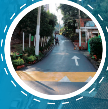
Vías restauradas: Calle Vieja, San Isidro y El Llano
